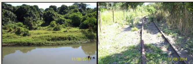
Acima: local onde era a ponte sobre o Rio Inhomirim. As vigas do Viaduto da Perimetral serviriam perfeitamente para reconstruir essa ponte. Acima, à direita, em Bongaba, trilhos seguem na direção Piabetá/Petrópolis.
